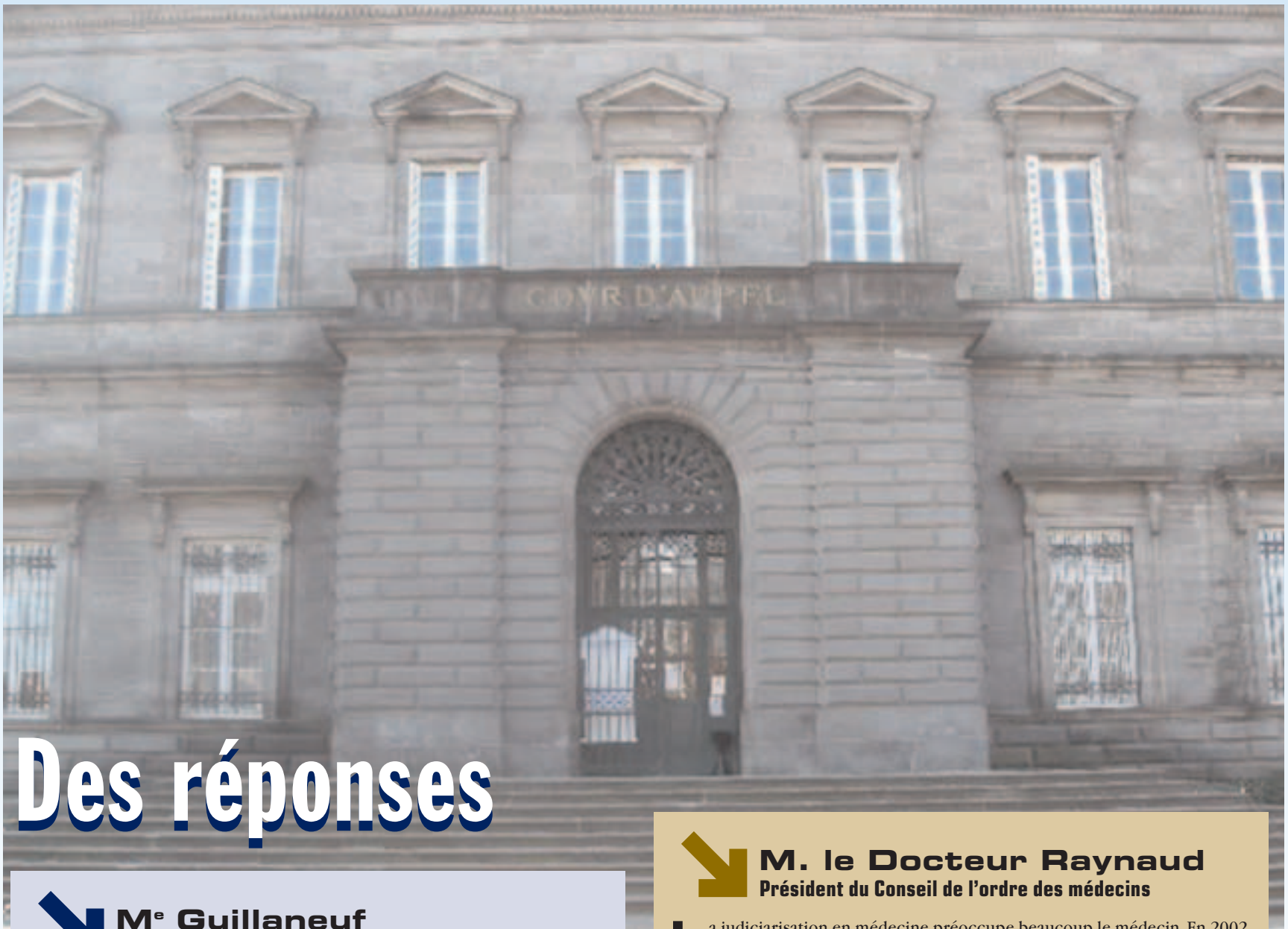
La cour d'appel de Riom, avant sa reconversion.
